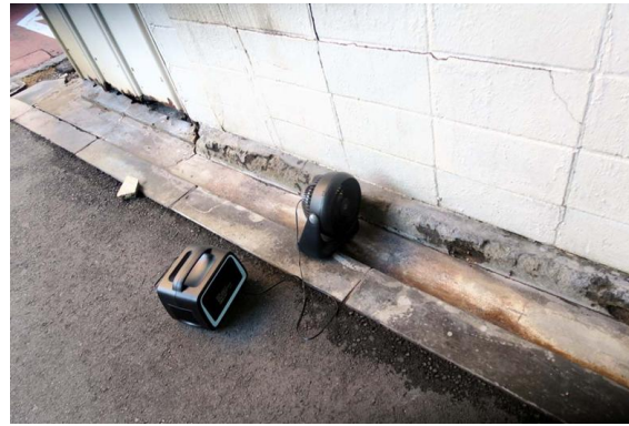
クリーニング作業後の側溝の状態(光触媒塗布前)
