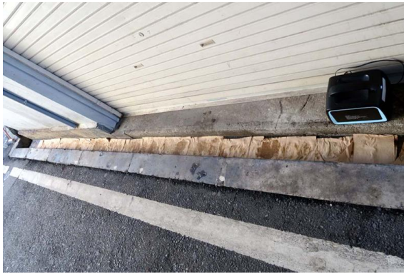
クリーニング作業後の側溝の状態(光触媒塗布前)
