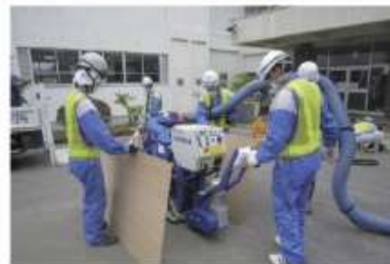
汚染されたアスファルト表面を吸い取っています
